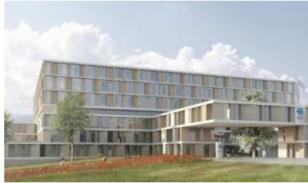
Kantonsspital Baden Neubau BGF 78.000 m 2
