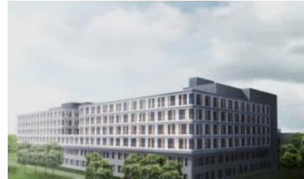
Universitätsklinikum Göttingen Neubau Funktionstrakt BGF 68.000 m 2
