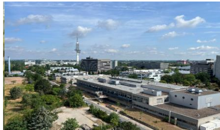
Neubau Medizinischen Hochschule Hannover Baustufe 1 BGF 98.000 m 2
