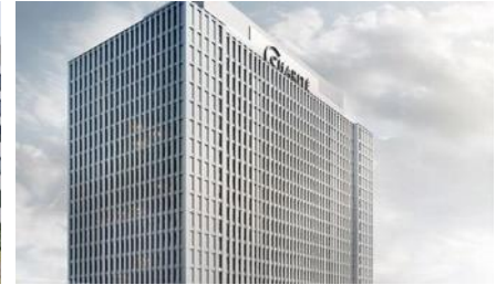
Charité - Universitätsmedizin Berlin Sanierung Bettenhaus, Neubau OP BGF 80.000 m 2
