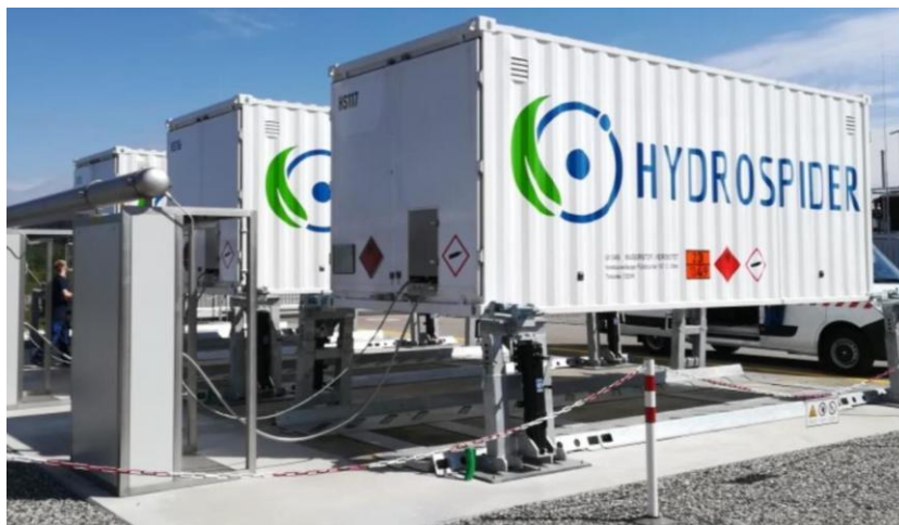
Obrázek 6: Plnicí stanice s logistickými komponenty pro výrobu a dodávku vodíku [89].
