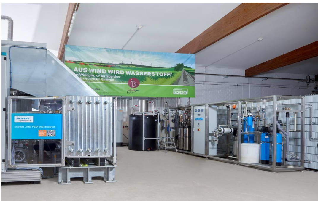
Obrázek 4: 1,25 MW el PEM elektrolyzér (vlevo) s úpravnou vody (vpravo) ve městě Haßfurt [67].
